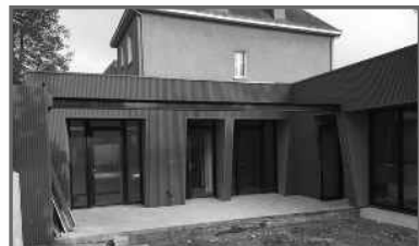
Isolation par l'extérieur avec bardage métallique
